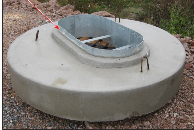
Betonivaluun tuleva vastakappale asennettuna betonikanteen.
