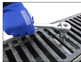
Sadevesikansissa / ritilöissä pulttikiinnitys
