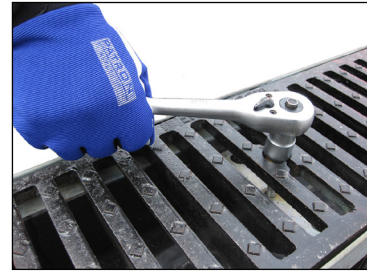
Sadevesikansissa / ritilöissä pulttikiinnitys.
